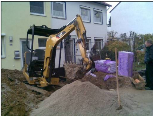
links: Baggerarbeiten auf dem Grundstück
