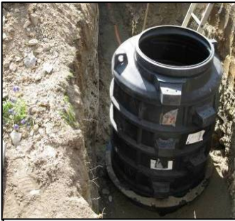
Abb.: Nachrüstung mit einem Kunststoffschacht
