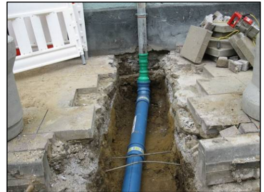
rechts: Erneuerung einer Regenwasserleitung in offener Bauweise
