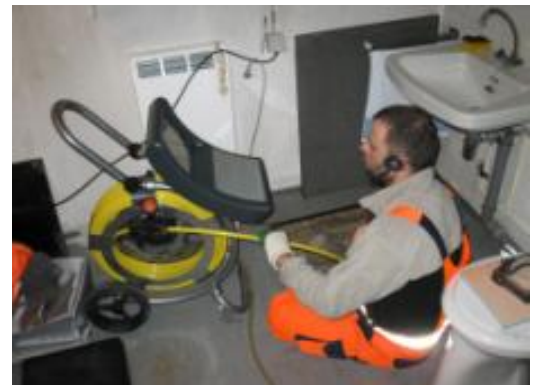
Kanal-TV-Inspektion in einer Kellerrevisionsöffnung mit einer Schiebekamera
