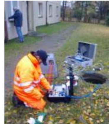
Durchführung einer Luftdruckprüfung
